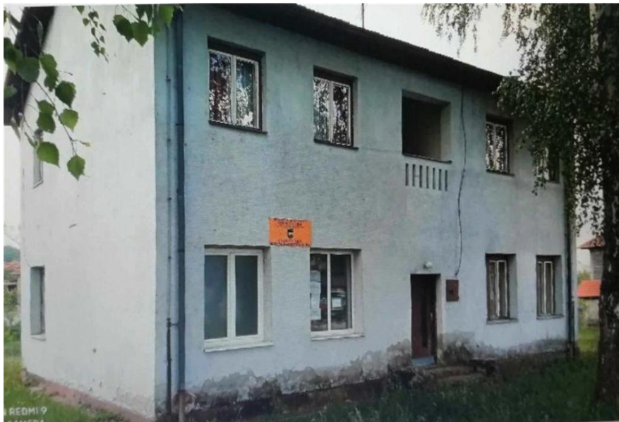
Slika 3. Izgled zgrade stare osnovne škole – sagrađena 1954.g.
