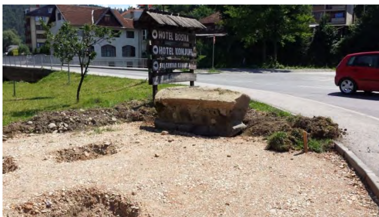
Foto: A. Mutapčić, radovi na izmještanju stećaka
