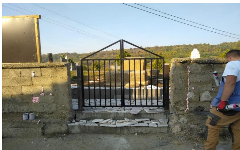
Slika br. 9. Postavljanje nove kapije i prilaza nekropoli
