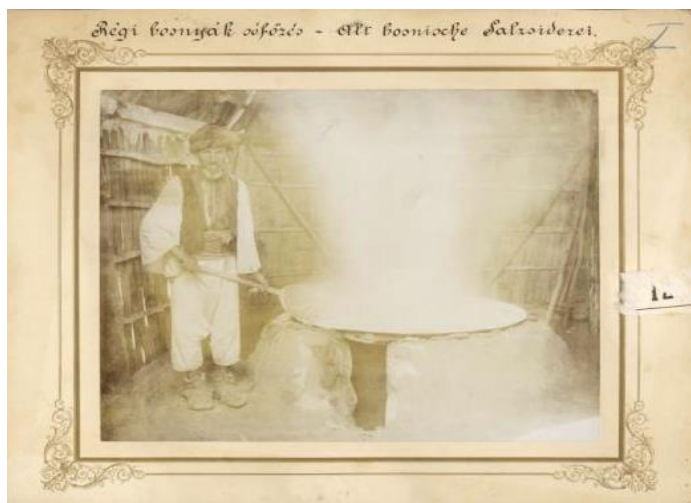
Slika 13. Primitivni način dobivanja soli iskuhavanjem, a na fotografiji je lokalni solar koji miješa zasoljenu vodu kašu u metalnoj tavi oslonjenoj na kamenu zidanu peć.
