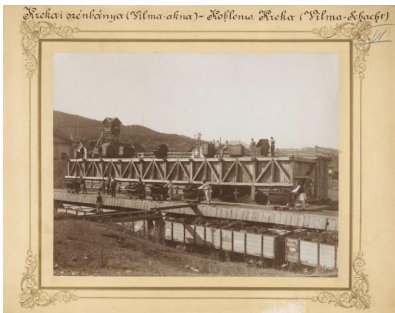
Slika 16. Manualni utovar uglja u vagone na utovarnoj rampi jame Vilma, prvog rudnika uglja na području Kreke. Uočljivo je da se utovar vrši na dva nivoa u paralelno postavljene vagone koji se transportuju željeznicom.
