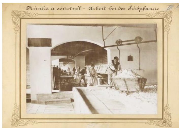
Slika 14. Vađenje soli čakljama iz kazana prikazano je u pozadini fotografije, a u prednjem planu je transport soli visećim vagonetima od kazana do sušnice u fabrici soli.
