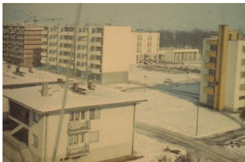
Sl.3 Izgradnja hotela "Konjuh" i okolnih stambeno-poslovnih zgrada
