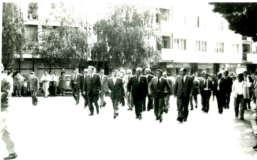
Šetnja raskrsnicom ispred hotela Gradačac, čija je namjena nažalost promjenjena
