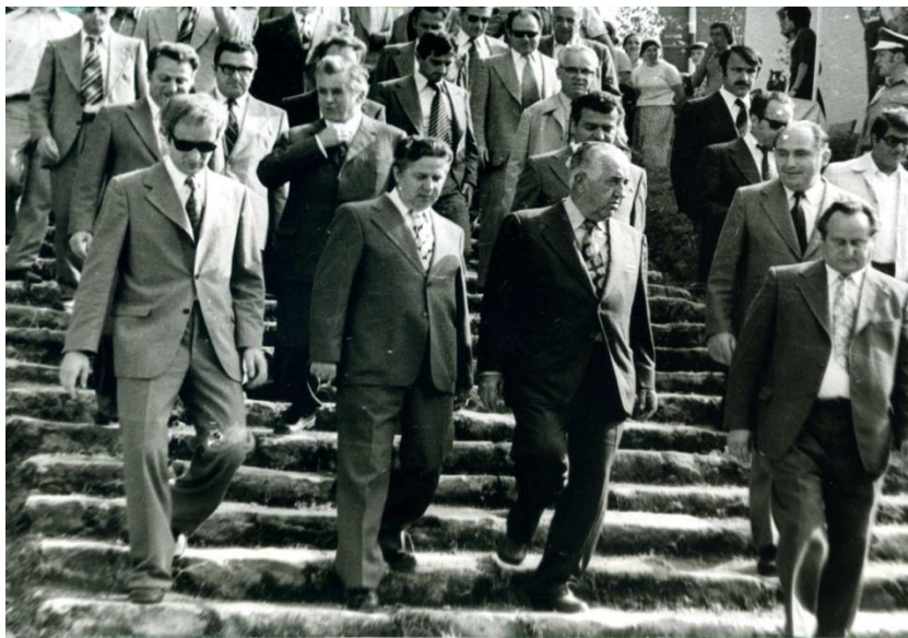
Na ulazu u otvoreni sajamski prostor
