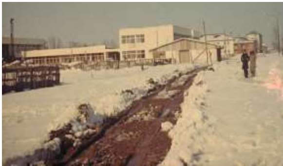
Sl.9 Komplex Doma zdravlja u izgradnji
