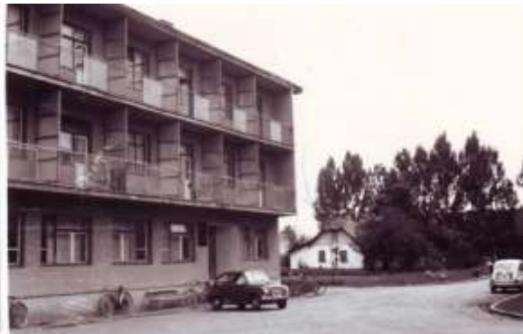
Sl.4 Ulica M. Tita - zgrada opštine
