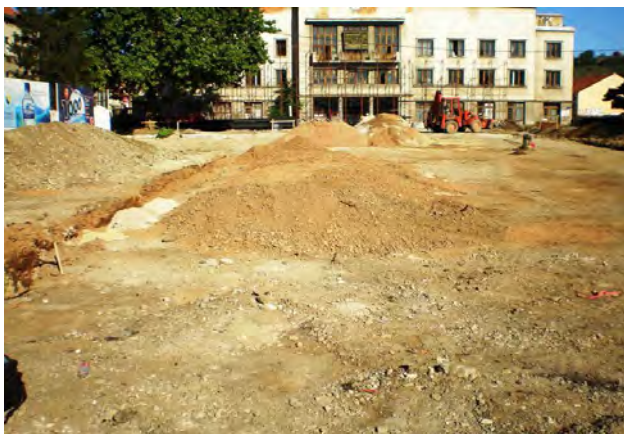
Trg slobode ljeto 2008. godine, radovi na rekonstrukciji
