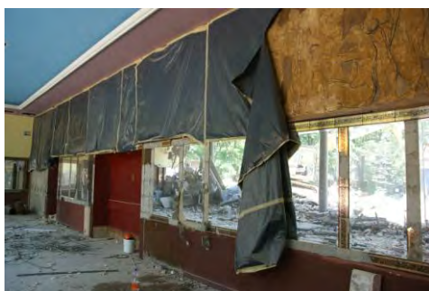
Privremena zaštita slike nakon početka građevinskih radova
